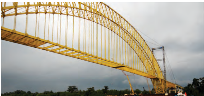
Project Name : JEMBATAN PELENGKUNG A-250 Client Name : PT. Waskita Karya Tonnage : 2.750 MT Location | Year : Teluk Masjid, Riau - Indonesia | 2007
